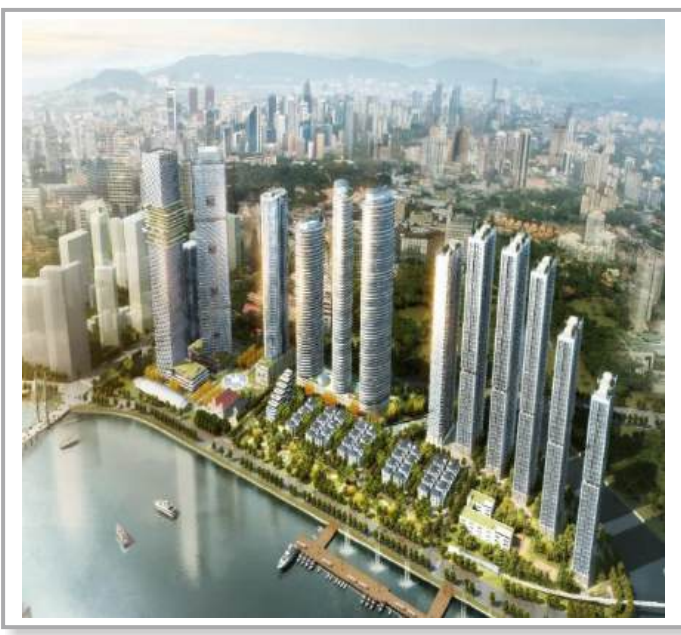
Công trình : Dự án The Sun Ba Son – Quận 1
