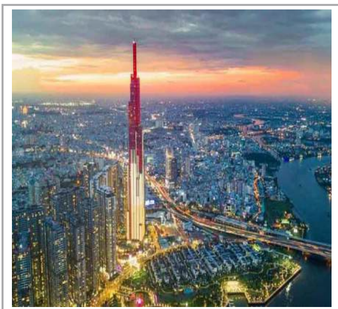
Công trình : Tòa nhà Wincom Centre Landmark 81 – Q. Bình Thạnh
