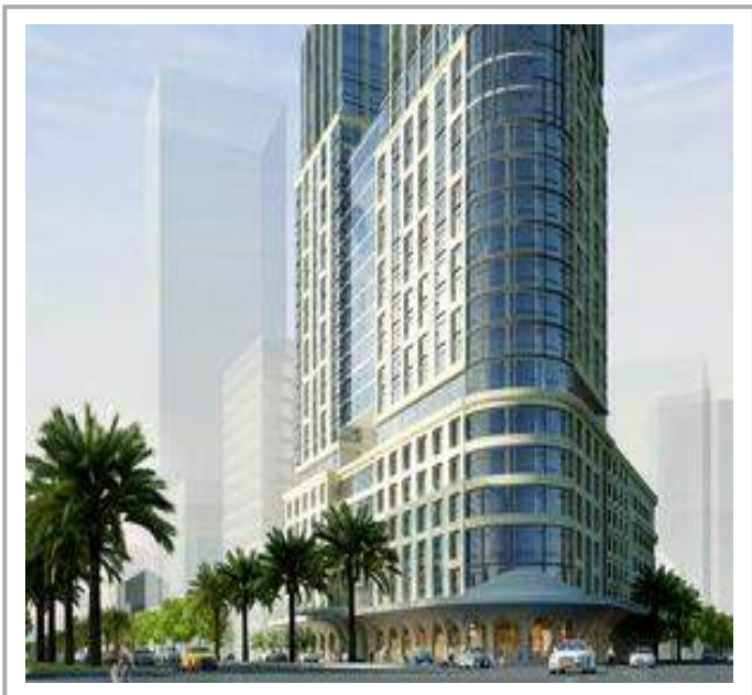
Công Trình : Mở Rộng Khách Sạn Cửu Long Majestic – Quận 1 Chủ Đầu Tư : Tổng Công Ty Du Lịch Sài Gòn (saigontourist)
