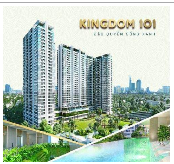
Công trình : Chung cư cao cấp KINGDOM 101 – Quận 10
