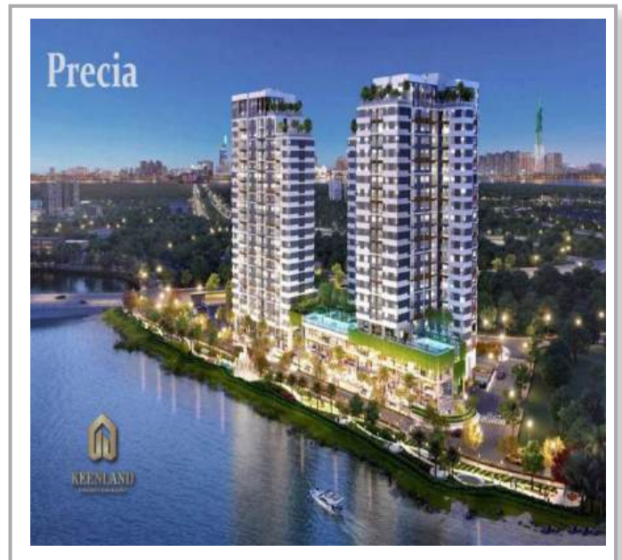
Công trình : Dự án khu dân cư Minh Thông – Quận 2
