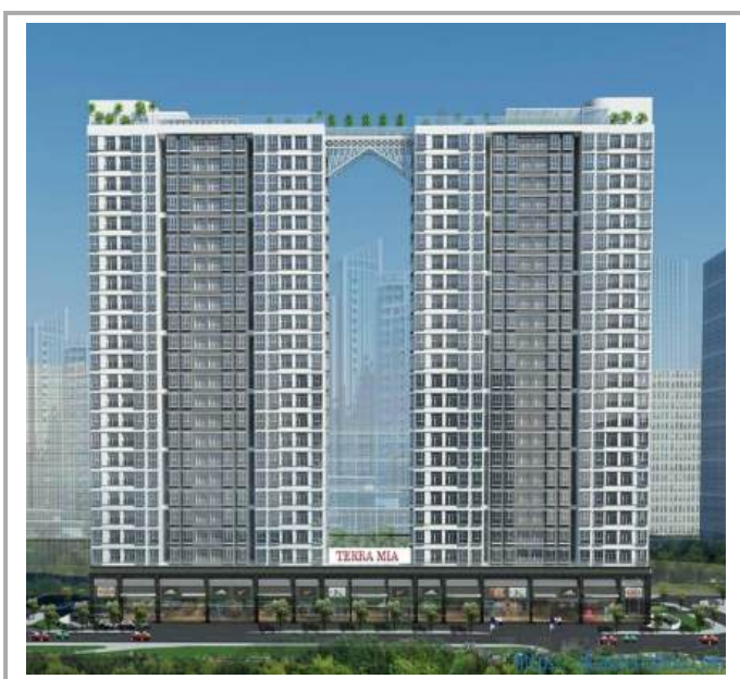
Công trình : Dự án căn hộ Beons Suối Tiên Bình Dương
