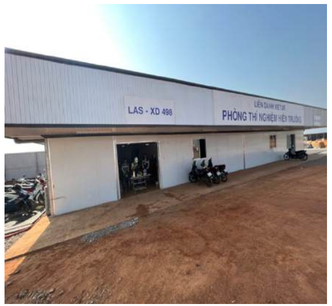
Phòng Thí Nghiệm Hiện Trường Las – Xd 498 Đặt Tại Công Trường Cảng Hàng Không Quốc Tế Long Thành
