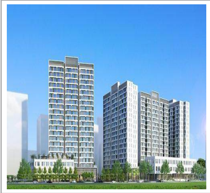
Công Trình : Chung Cư Cao Tầng Và Thương Mại Lô H1 – 04 – Quận 2 Chủ Đầu Tư : Công Ty TNHH Đầu Tư Vĩnh Phú
