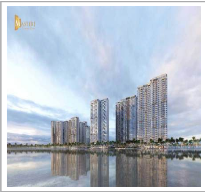
Công trình : Dự án MASTERI CENTRE POINT – Quận 9
