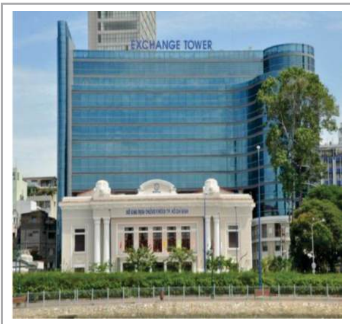
Công trình: Sở Giao Dịch Chứng Khoán Tp.HCM Chủ Đầu Tư : Sở Giao Dịch Chứng Khoán Tp.HCM(Hose)
