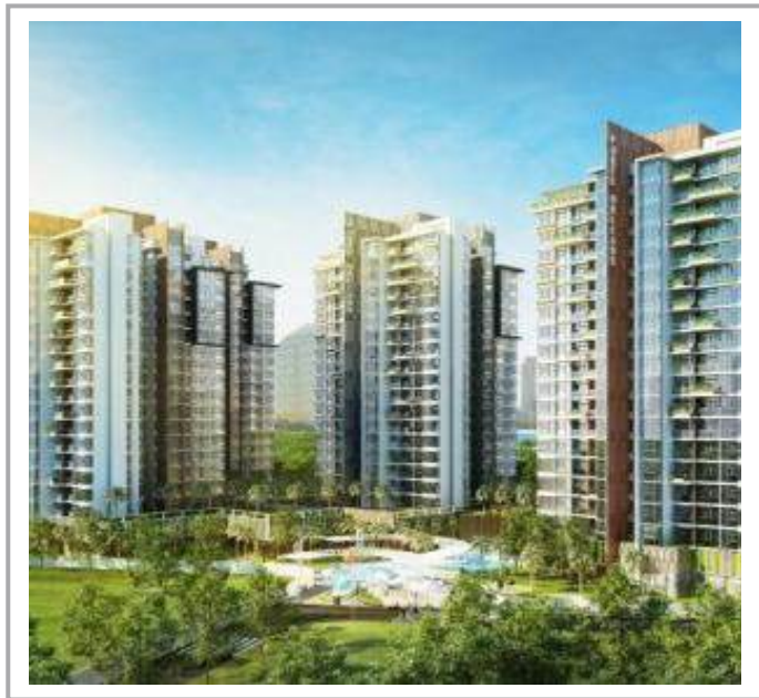
Công trình : Căn Hộ Gateway Development Bình Dương Chủ đầu tư : Công Ty TNHH Phát Triển Visip - Sembcorp
