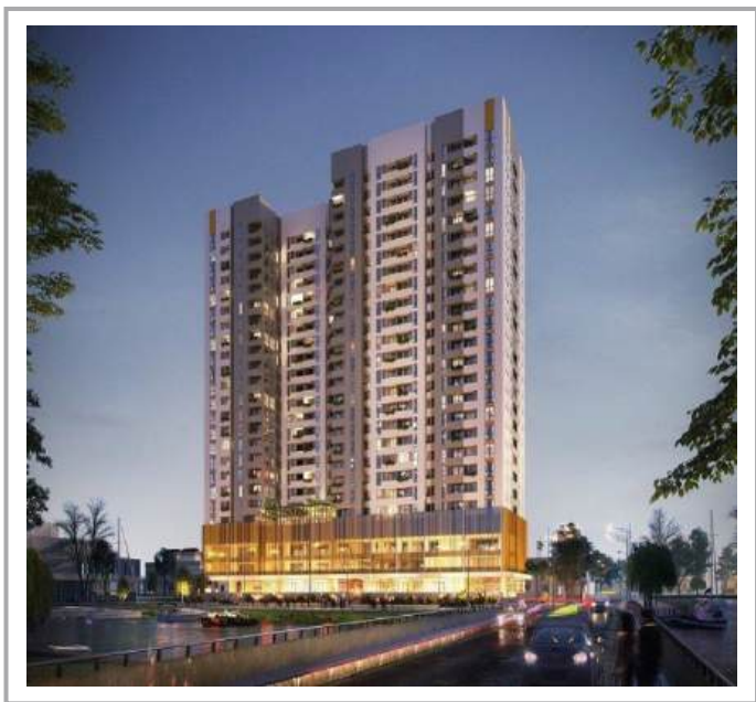
Công trình : Dự án Aurora Riverside – Quận 8
