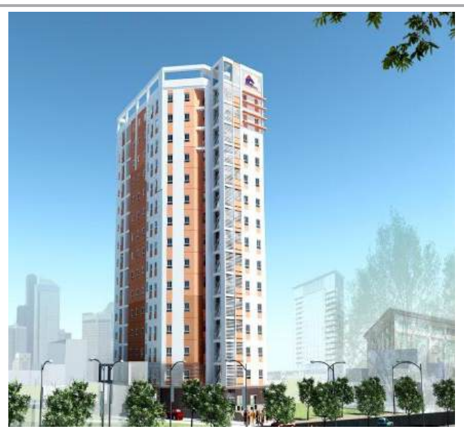
Công Trình : Chung Cư Cao Tầng Khang Gia – Quận 8 Chủ Đầu Tư : Công Ty CPĐT PT Địa Ốc Khang Gia
