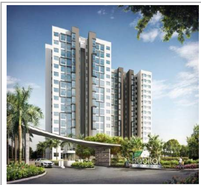
Công Trình : Dự Án Căn Hộ The Habitat Bình Dương Chủ Đầu Tư : Công Ty TNHH Phát Triển Visip-semcorp
