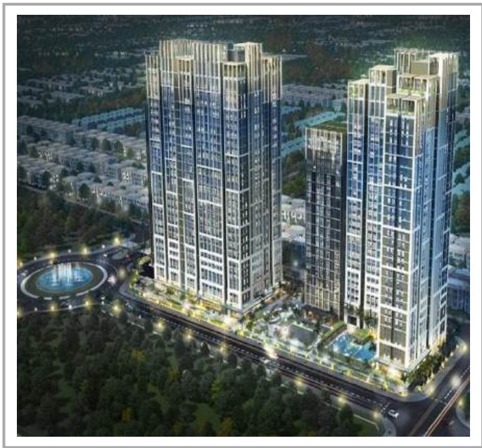
Công trình : Khu căn hộ cao cấp Opal Boulevard -Q. Thủ Đức
