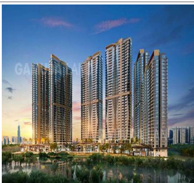
Công Trình : Khu Nhà Ở Tâm Lực – Tp. Thủ Đức
