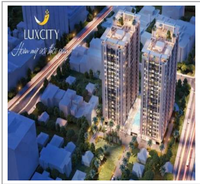
Công Trình : Căn Hộ Luxcity – Huỳnh Tấn Phát – Quận 7 Chủ Đầu Tư: Công Ty Cổ Phần Dịch Vụ & XD Địa Ốc Đất Xanh
