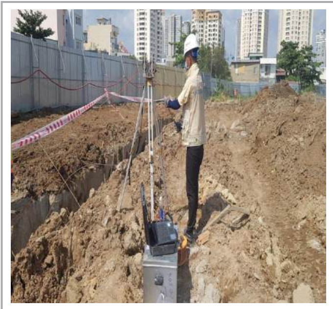
Thí nghiệm kiểm tra chất lượng cọc khoan nhồi tại công trường
