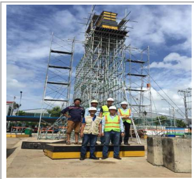
Thí nghiệm kiểm tra chất lượng an toàn chịu tải của giàn giáo tại công trường
