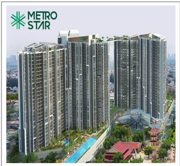
Công trình : Dự án căn hộ Metro Star – Quận 9
