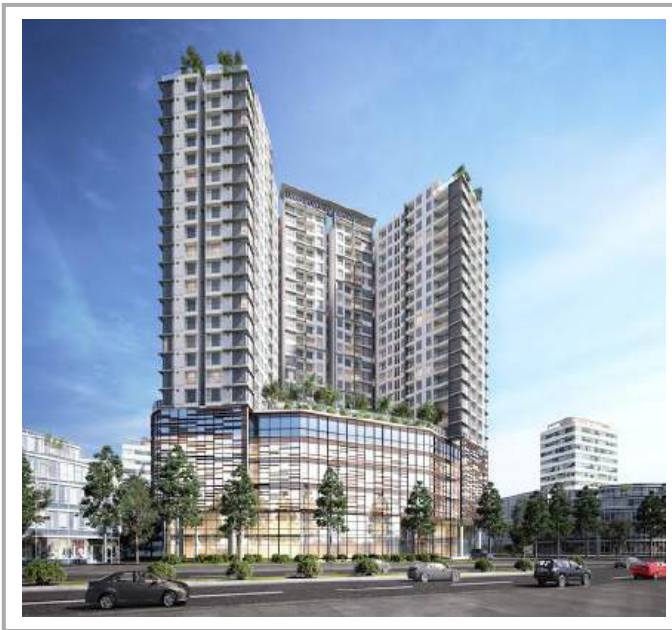
Công Trình : The Everrich Infinity – 290 An Dương Vương – Q.5 Chủ Đầu Tư : Công Ty CP Phát Triển BĐS Phát Đạt
