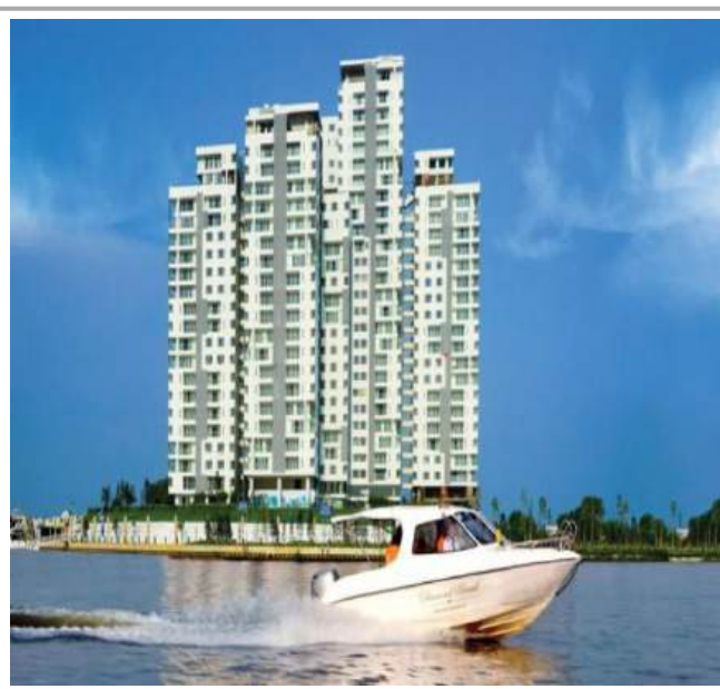
Công Trình : Dự Án Căn Hộ Diamond Island – Quận 2 Chủ Đầu Tư : BTA Việt Nam
