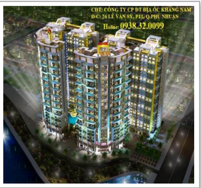
Công Trình : Căn Hộ Terra Rosa – Q. Bình Chánh Chủ Đầu Tư: Công Ty Cổ Phần Đầu Tư Địa Khang Nam
