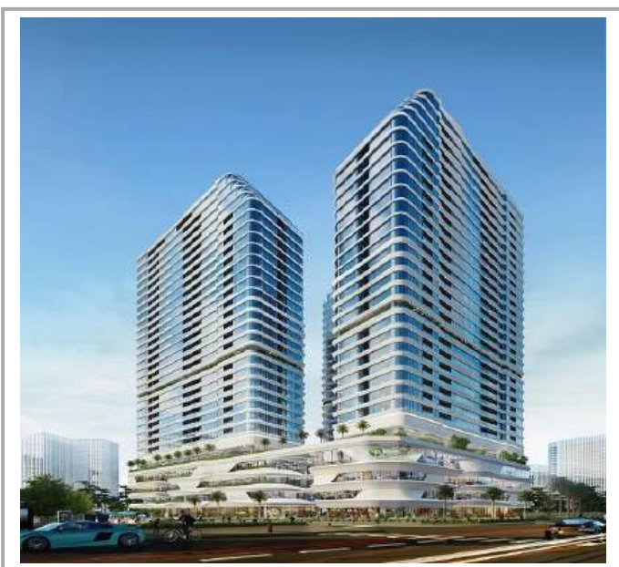
Công trình : Dự án căn hộ King Crown Infinity – Q. Thủ Đức
