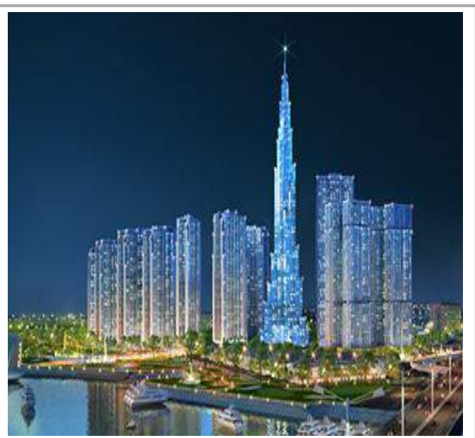
Công Trình : Dự Án Vinhomes Central Park Tân Cảng – Tp.HCM Chủ Đầu Tư : Tập Đoàn Vingroup
