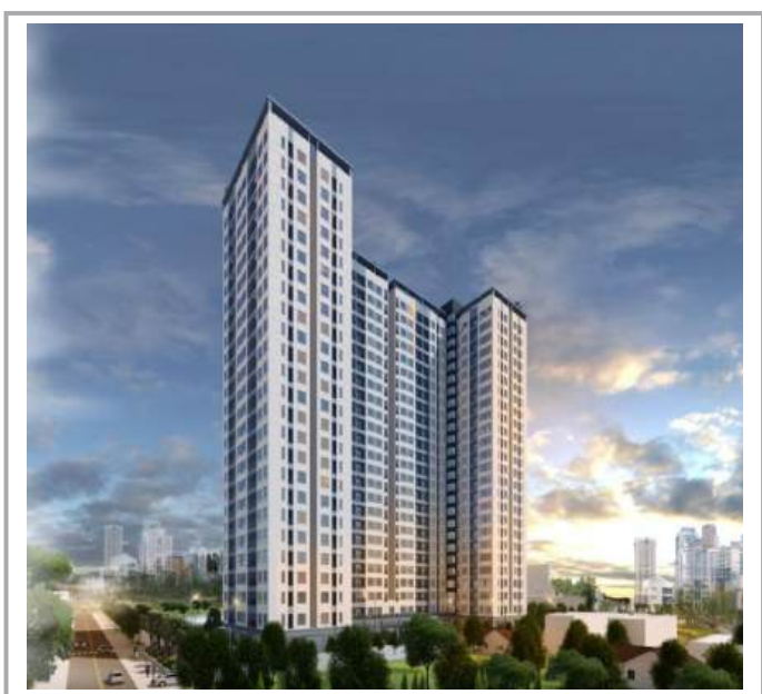
Công trình : Khu căn hộ TERRA MIA - Bình Chánh
