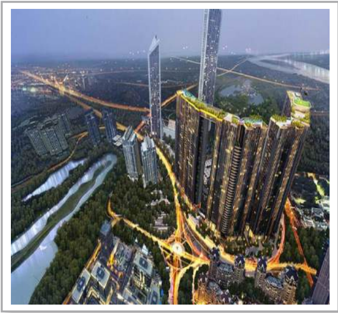
Công trình : Dự án Sunshine City Sài Gòn – Quận 7
