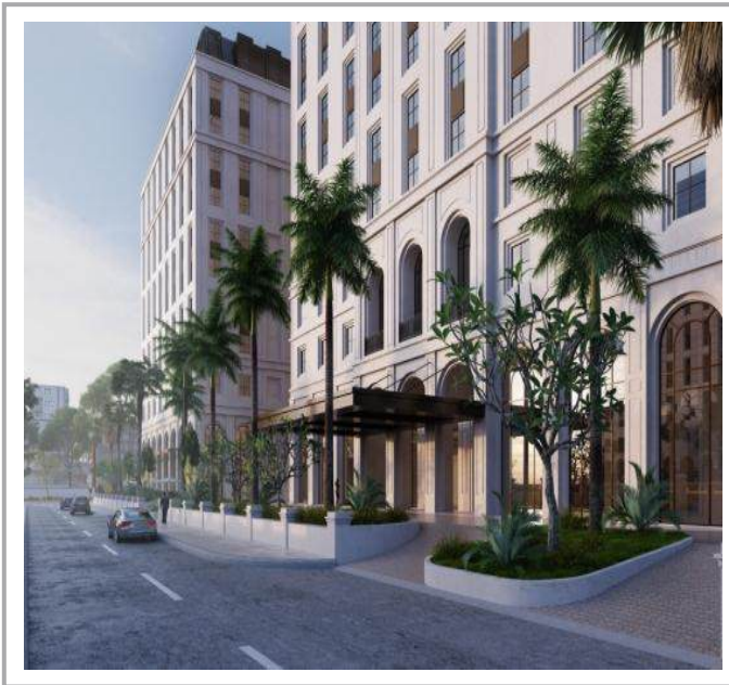
Công Trình : Khách Sạn Marie Curie Hotel – Quận 3 Chủ Đầu Tư : Công Ty TNHH Bất Động Sản Areco
