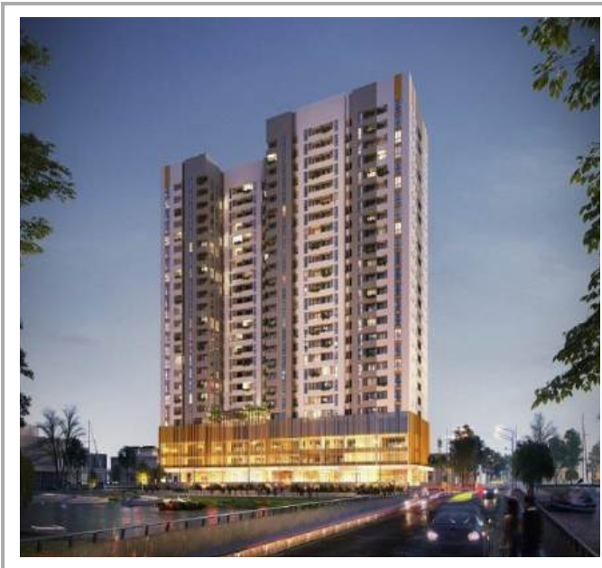
Công trình : Dự án Căn hộ AURORA RESIDENCES– Quận 8
