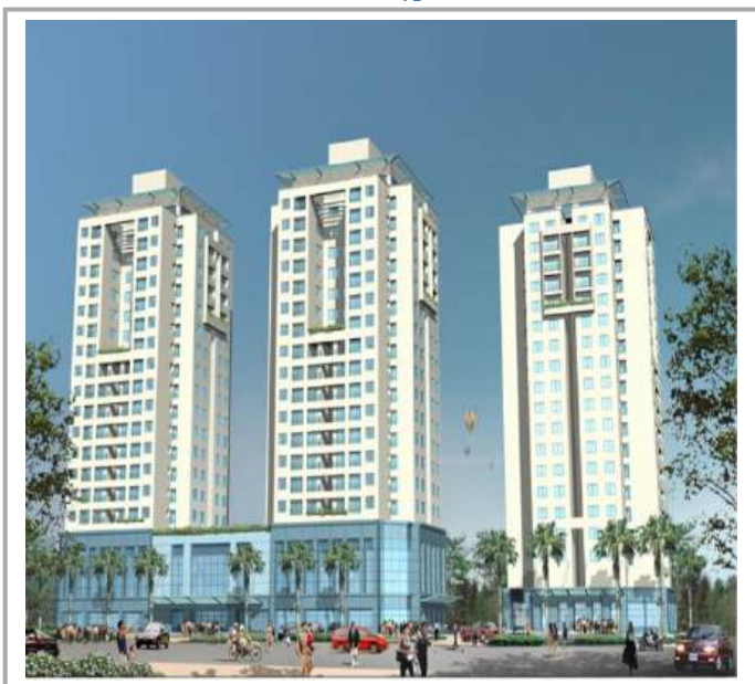
Công Trình :khu Chung Cư Thành Thái – Quận 10 Chủ Đầu Tư: Công Ty CPĐT & PT Đô Thị Long Giang
